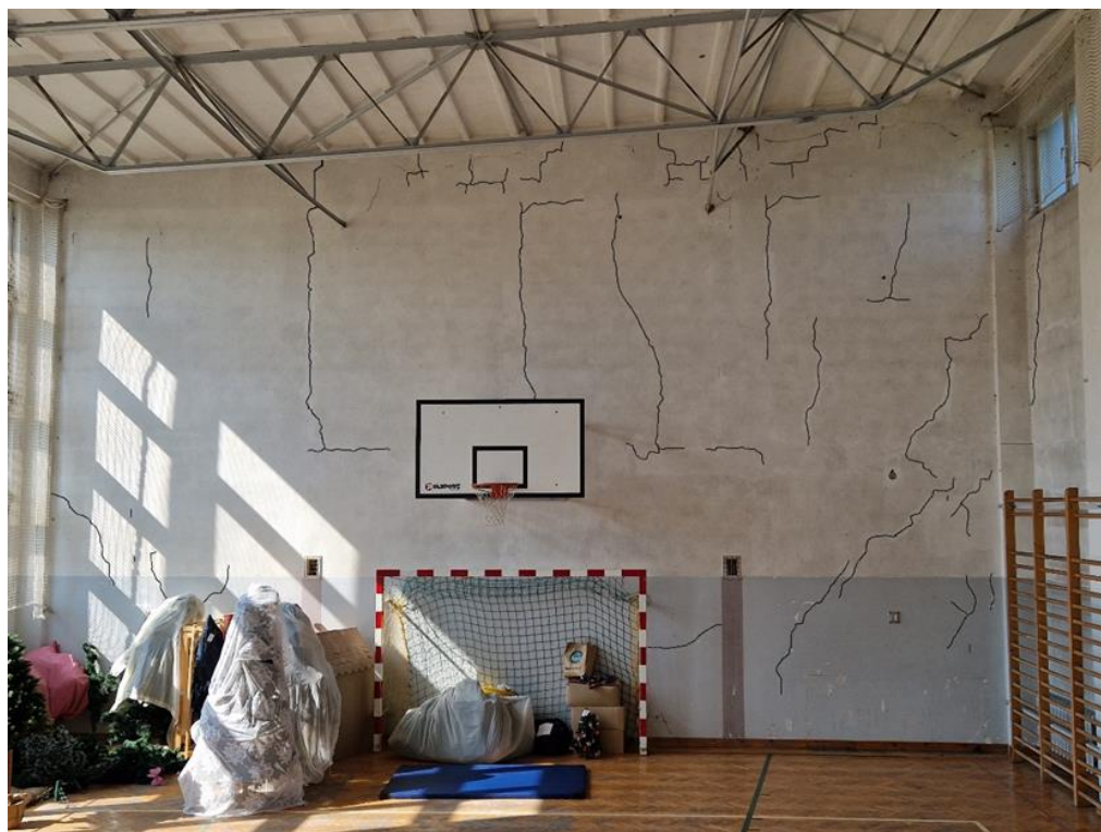
Fot. 2. Widok zarysowań ściany zachodniej sali gimnastycznej.
