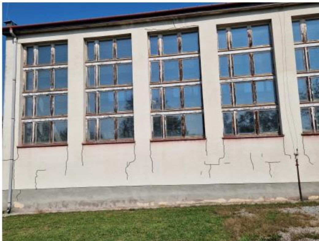
Fot. 6. Widok zarysowań elewacji południowej cz. I.
