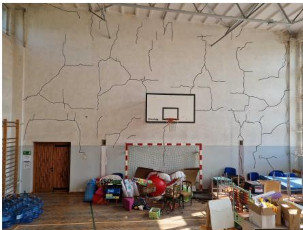
Fot. 1. Widok zarysowań ściany wschodniej sali gimnastycznej.
