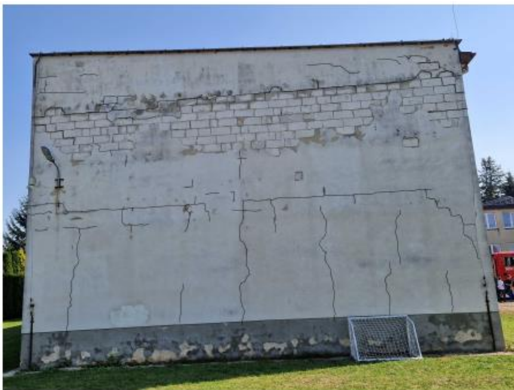
Fot. 3. Widok zarysowań elewacji zachodniej sali gimnastycznej.
