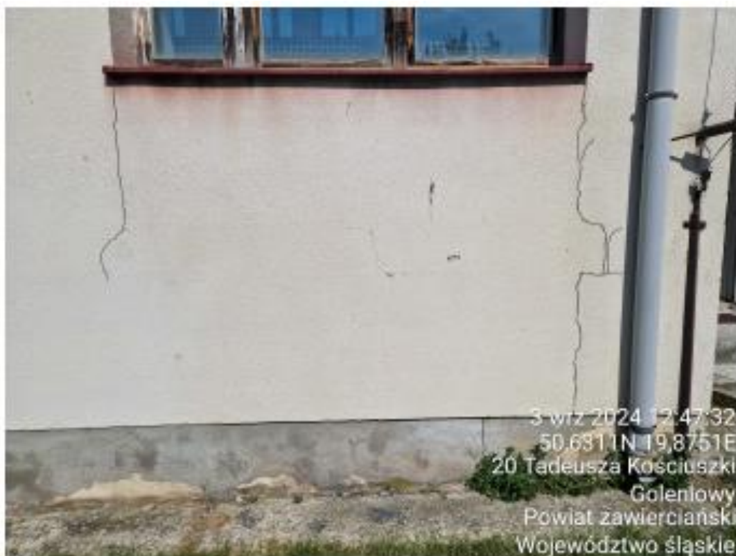
Fot. 7. Widok zarysowań elewacji południowej od strony wschodniej ściany szczytowej.
